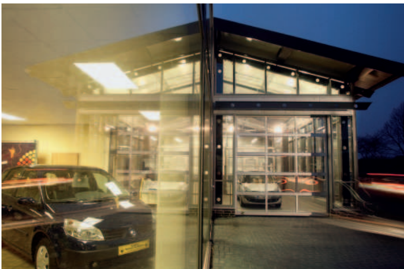
Eine moderne und transparente Fassade, dank Modularbauweise
